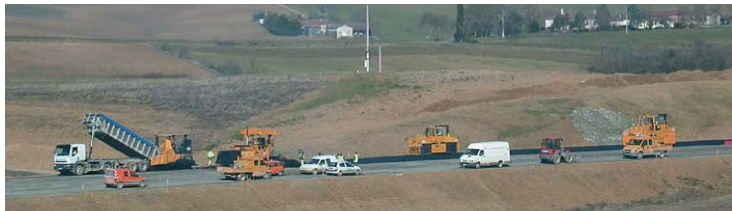
Construction de la déviation d'Aubiet
